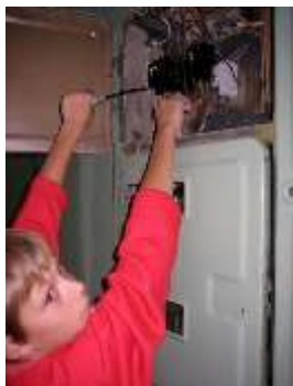
Фото 1. Нарушение правил подключения к источнику электрической энергии
