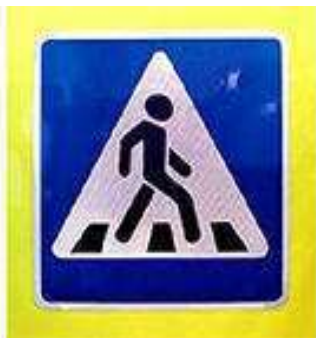
Фото 31. Предупреждающий дорожный знак «Пешеходный переход»
