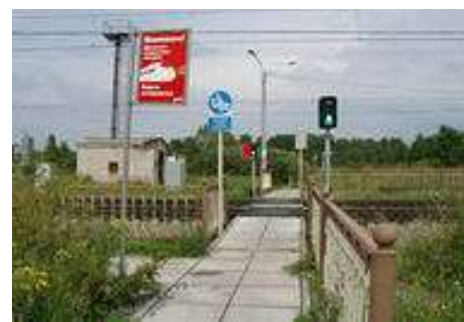
Фото 44. Стационарные переходы через железнодорожные пути
